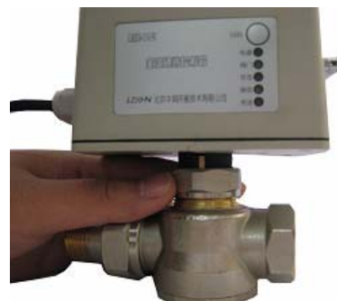
图 8 室温控制器与阀体的安装
